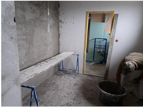
Mit dem Grobputz wird die Wand zunächst aufgefüllt und vorgeglättet, bevor der Feinputz den Abschluss bildet.
