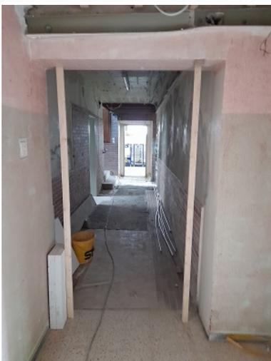
Im Flur zwischen den Sanitärräumen und den Gästezimmern wird der Durchgang verschmälert, um hier eine Feuerschutztür einbauen zu können, die das Brandschutzkonzept vorschreibt.
