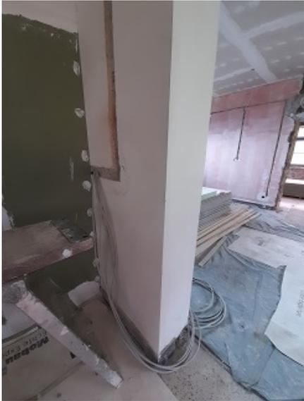
... und ein dickes Bündel Stromleitungen quillt unter der neuen Wand hervor und wartet auf seine fachgerechte Verlegung. Die Wand rechts vorne ist jedenfalls dafür schon geschlitzt.
