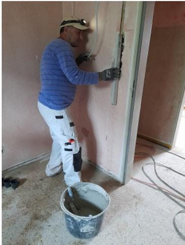
Auch die Verlegung der Elektroleitungen macht hier unten weitere Fortschritte: Wände werden geschlitzt und Litzen verlegt.
