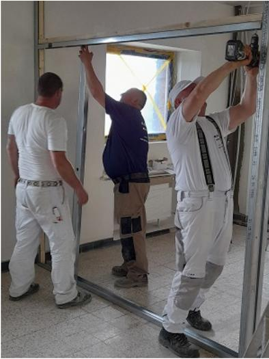
In der oberen Etage unseres Hauses geht es weiter mit dem Bau von Wänden der Bistroküche im Ausstellungssaal, die dort abgetrennt wird. Es werden waagerechte Verstrebungen eingezogen, um die vom Denkmalschutz vorgeschriebenen Fensterflächen im oberen Bereich zu ermöglichen.
